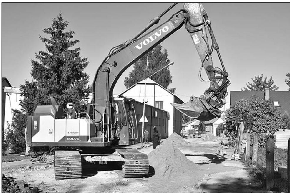
Pašlaik darbi norit dažādos atsevišķos ielas posmos – citur jau tiek liktas betona apmales, bet citviet notiek apakšzemes komunikāciju izbūve.
